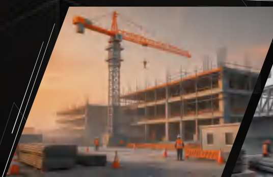
建筑工地 Construction site
