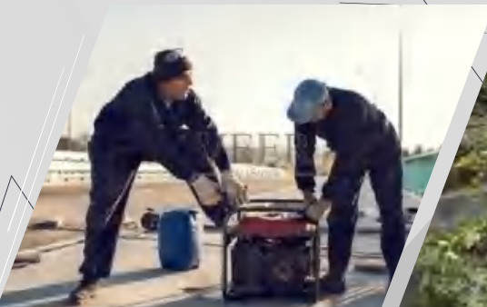
建筑工地 Construction site
