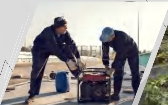
建筑工地 Construction site
